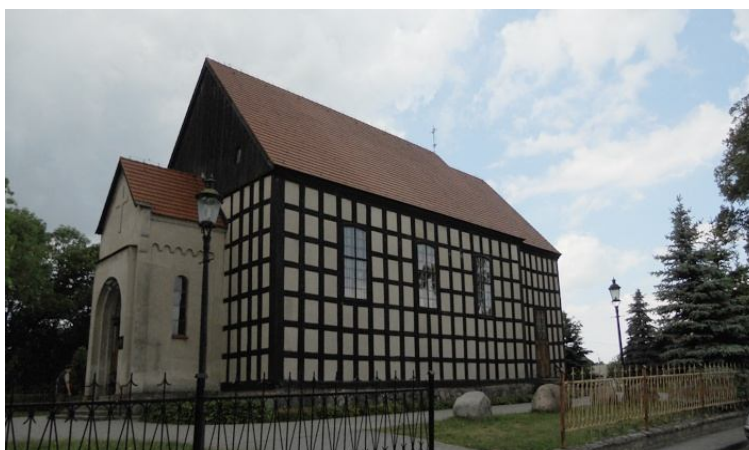
Fot.8. Kościół p.w. św. Katarzyny w Sypniewie (autor: A. Krupa).
